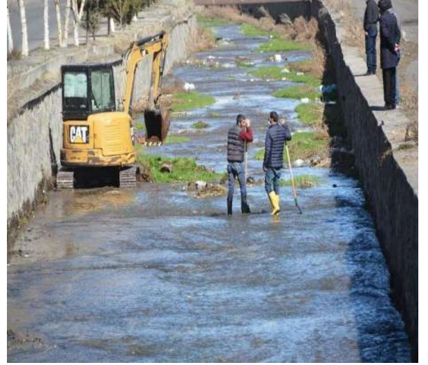
Dere Yataklarının Temizliği
